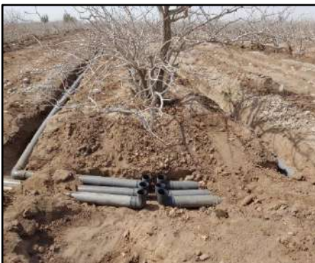
شکل ۲۳- آبیاری زیرسطحی کم‌فشار با لوله‌های پی‌وی‌سی
